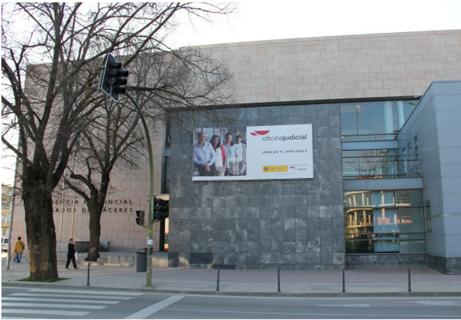
Figura 22. Cartelería exterior en la Oficina Judicial de Cáceres.
